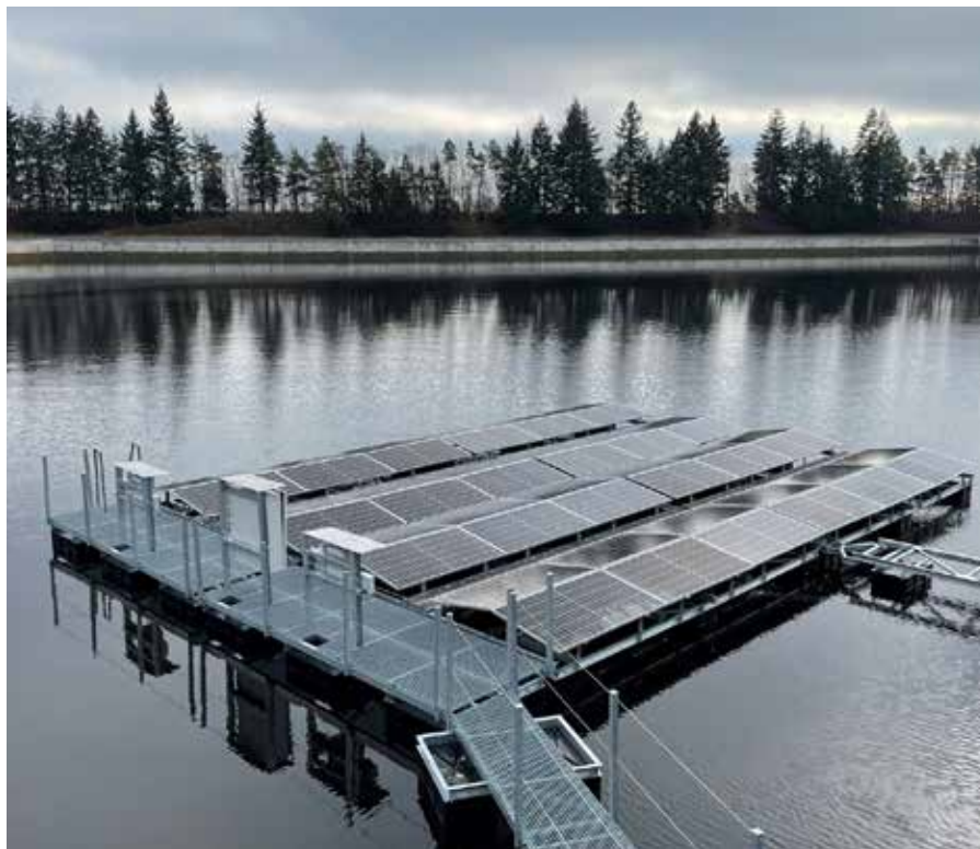
◀ Plovoucí FV panely v nádrži na Homoli. (Zdroj: ČEZ)
